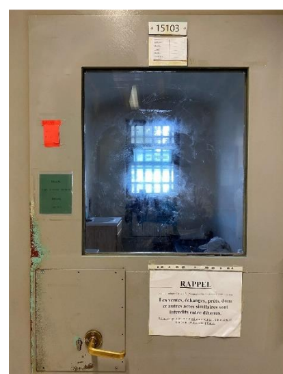
Annexe : porte de cellule vitrée
