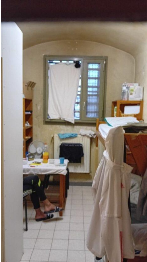
Fenêtre manquante – cellule 3225
